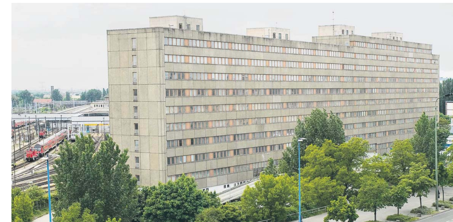
Viel Phantasie: Der Eigentümer dieses Betonkolosses siebt keinen Schandfleck, sondern eine ideale Hülle für 47 Wohnungen je Stockwerk. Foto Bauundgrund
